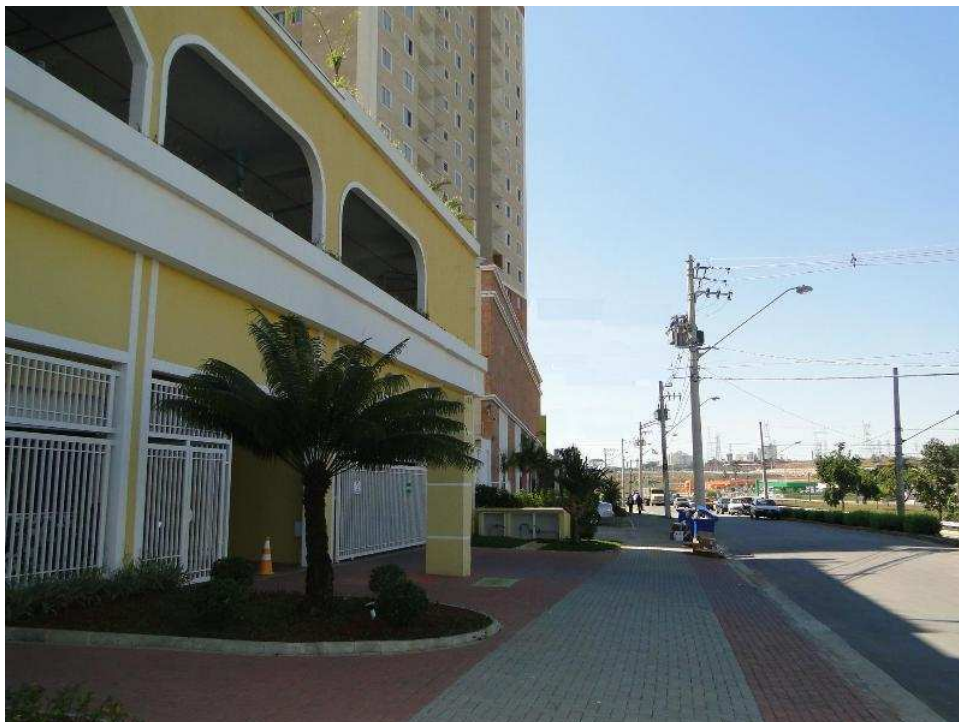
Prédio com Ramal de Entrada Subterrâneo
