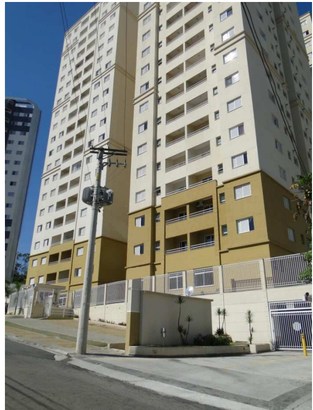
Prédio c/ Ramal de Entrada Subterrâneo
