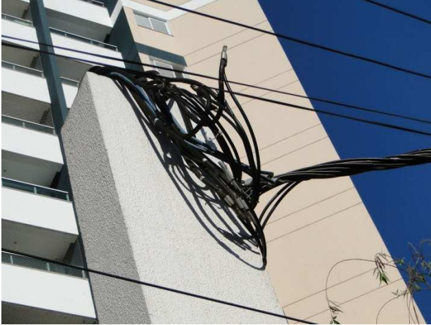
Exemplos de “congestionamento” de condutores de ramal de ligação/entrada
