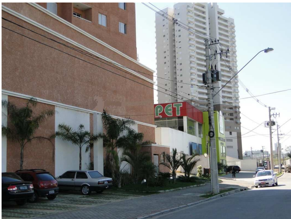
Prédio com Ramal de Entrada Subterrâneo
