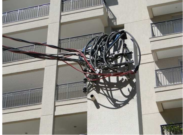
Exemplos de “congestionamento” de condutores de ramal de ligação/entrada
