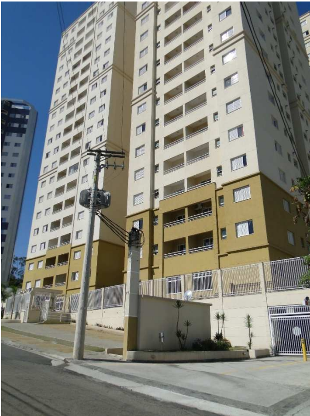
Prédio c/ Ramal de Entrada Aéreo
