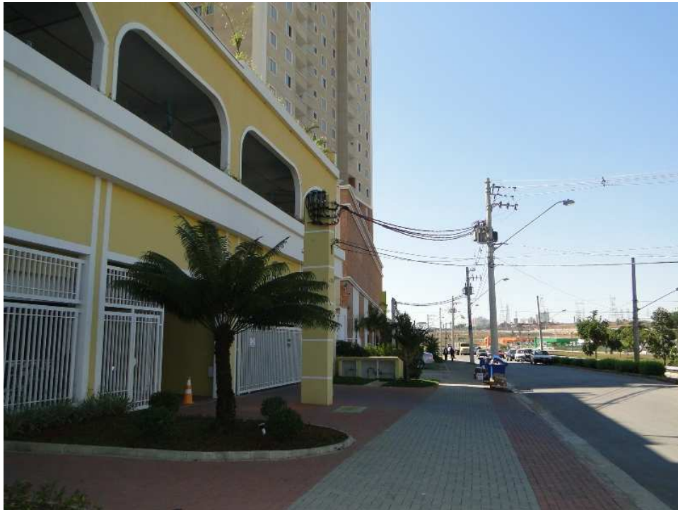
Prédio com Ramal de Entrada Aéreo
